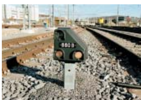
230 Zwergsignale sind Bestandteil der komplexen Infrastruktur
