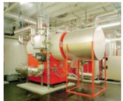
Blockheizkraftwerk für die Wärmeerzeugung
